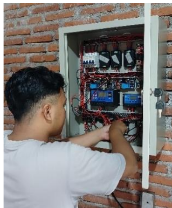
Gambar 9 - Pemasangan Instalasi Alat
