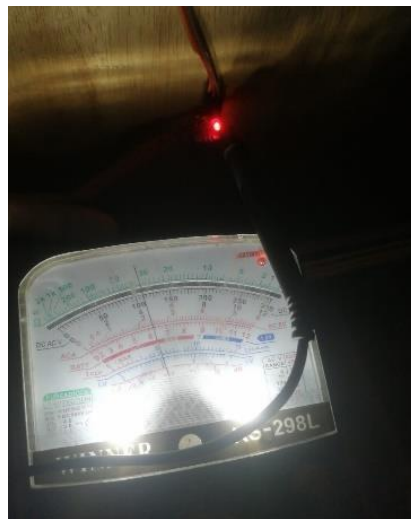
Gambar 11. Uji Sensor DHT
