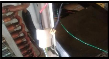
Gambar 15. Pengujian Sistem Pengkabelan dengan Mencopot Kabel Sensor Suhu
