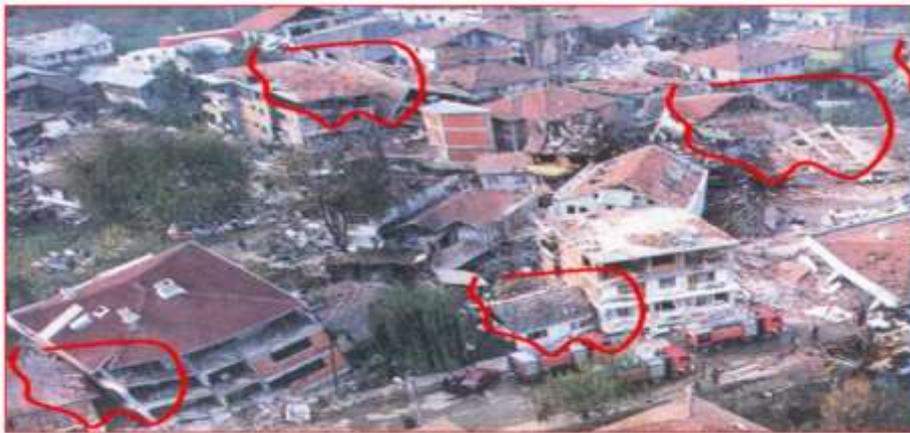
Gambar 1. Gedung gedung yang mengalami kontak setelah terjadi gempa
