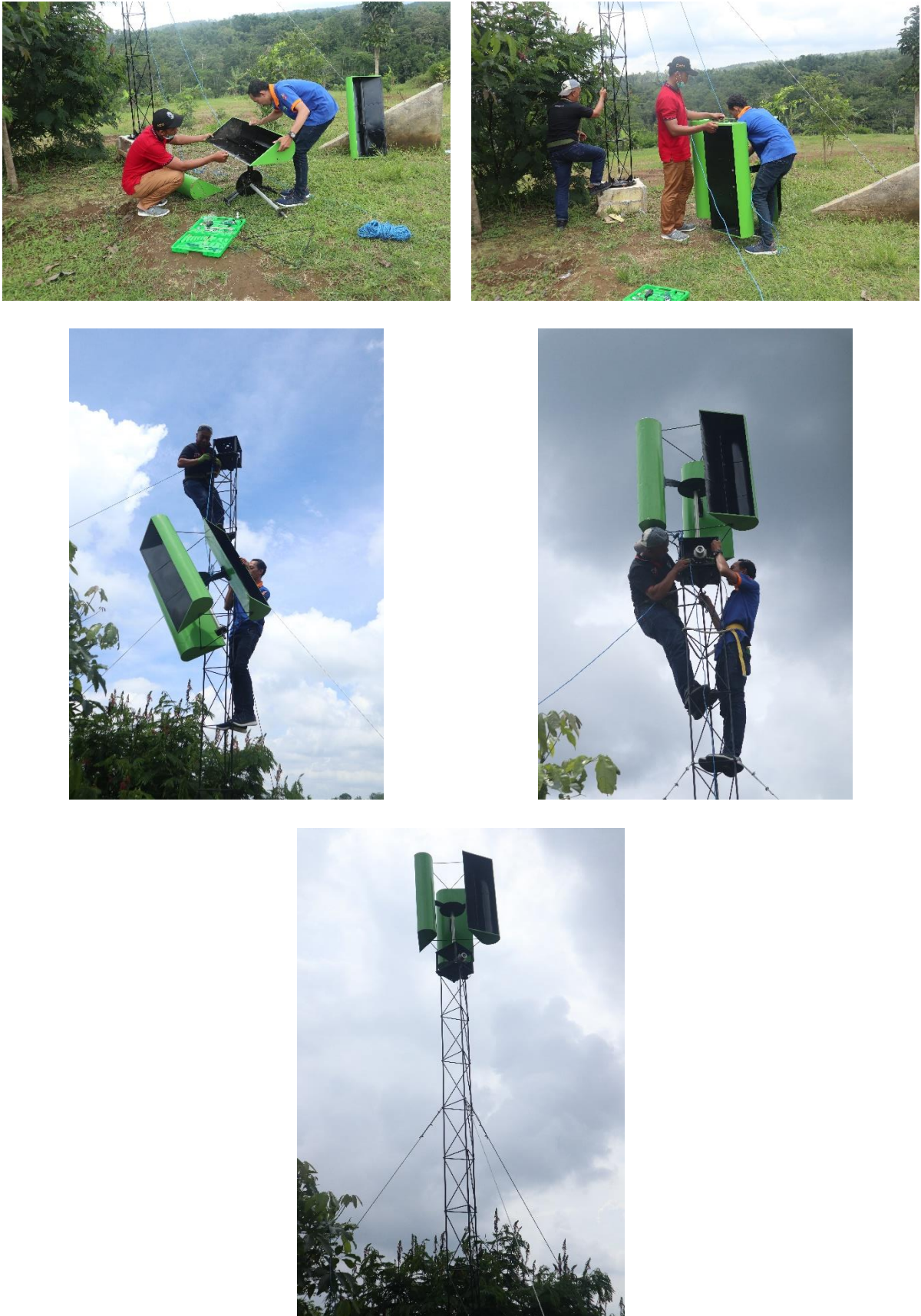
Gambar 8. Proses Pemasangan Pembangkit Listrik Tenaga Bayu Skala Kecil di SMKN 1 Wonosari
