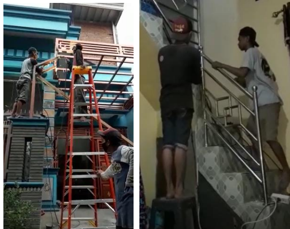
Gambar 6. Hasil pengerjaan lengkungan
