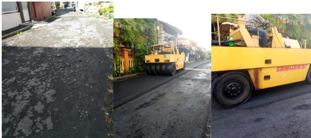
**Gambar 7.** Blok G awal (kiri), Blok F sudah aspal (tengah), Blok F sedang aspal (kanan)
