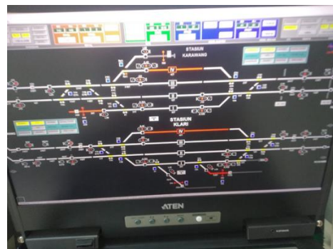
Gambar 4. Video Display Unit pada Equipment Room
