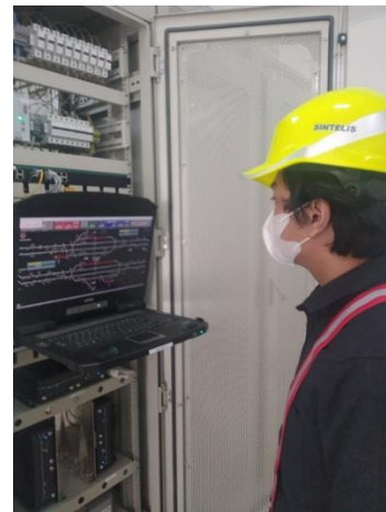
Gambar 5. Pengecekan VDU Setelah dilakukan Restart
