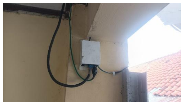
Gambar 11. Penghubungan kabel power dan kabel lampu
