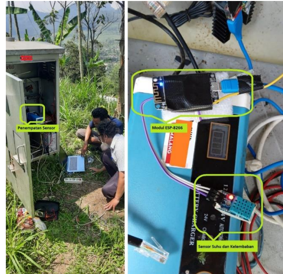
Gambar 4. Pemasangan perangkat IoT pada repeater di puncak bukit.
