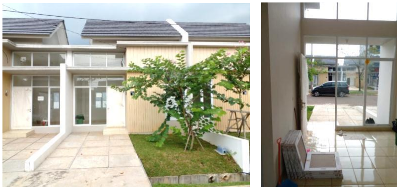
Gambar. 1 Tampak Depan dan Kondisi Dalam Ruang Sampel Penelitian Sumber: Survei, Agustus 2022
