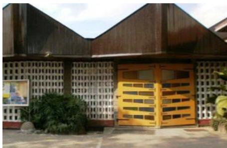
**Gambar 13.** Dinding memiliki lubang untuk ventilasi dan tempat masuknya cahaya. (destiasuwoyo.wordpress.com, 2014)
