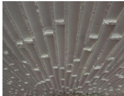
**Gambar 14.** Bekisting dari material bambu yang membentuk corak yang indah (Tektan.tumblr.com,2013)
