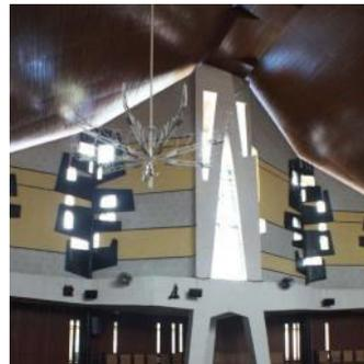
**Gambar 8.** Lubang cahaya pada dinding depan gereja (tektan.tumblr.com, 2013)
