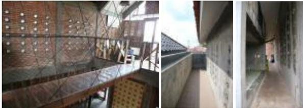
**Gambar 5.** Penerapan material dinding kombinasi batu bata dengan botol-botol bekas (Survey Lapangan, 2019)
