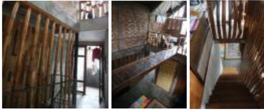
**Gambar 10.** Penerapan material daur ulang pada ornamen railing tangga dan jembatan gantung (Survey Lapangan, 2019)
