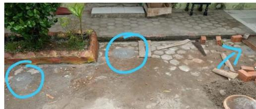
**Gambar 11.** Pembuatan lubang resapan biopori di area lapangan MI Nurul Falah
