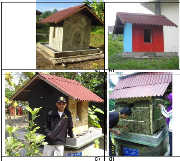
**Gambar 3.** Empat ragam lapisan pengolahan dinding fasad: a).Model fasad rumah plesteran, b). Model fasad rumah di cat, c).Model fasad rumah berlapis batu alam d)., dan d). model fasad rumah berlapis tanaman
