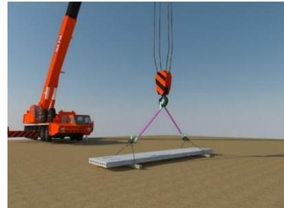
**Gambar 13.** Sketsa Pemasangan Sling baja Pada *Hollo Core Slab*
