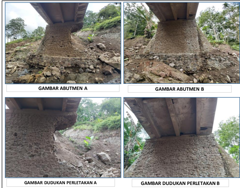
Gambar 4. Pengamatan Abutmen dan Perletakan
