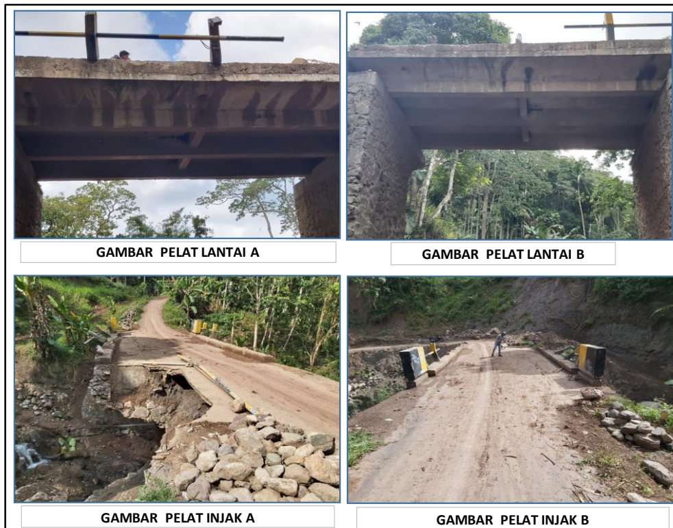
Gambar 5. Pengamatan Pelat Lantai Kendaraan
