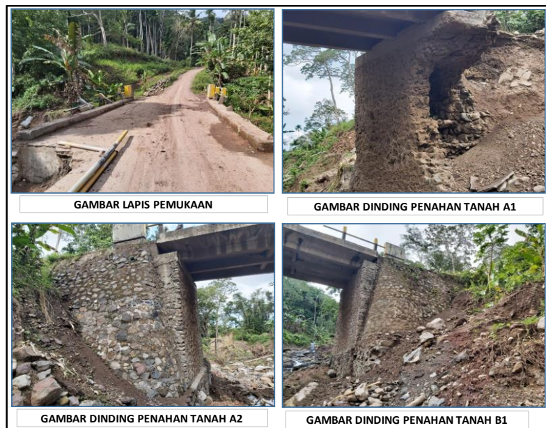
Gambar 6. Pengamatan pada Dinding Penahan Tanah
