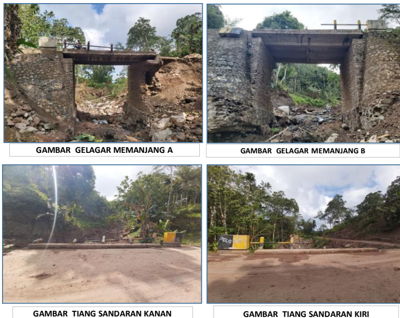
Gambar 3. Pengamatan Gelagar Memanjang dan Tiang Sandaran
