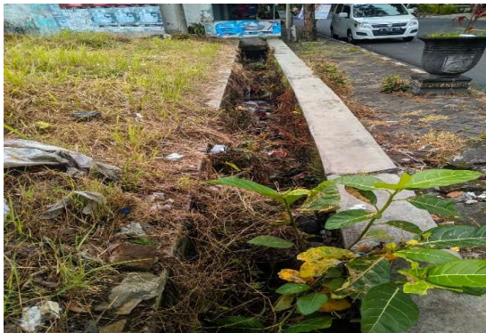
Gambar 3. Kondisi Saluran eksisting yang terganggu akibat sedimen dan sampah
