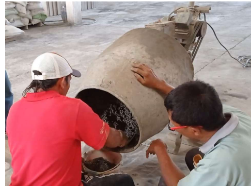
Gambar 3. Pekerjaan Campuran Material
