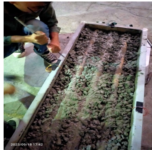
Gambar 4. Pencetakan Material ke Bekisting Plat
