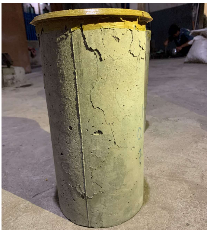
Gambar 4. 1Pola Retak Beton Pada Pengujian Kuat Tekan
