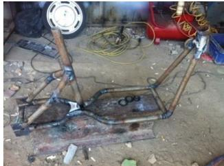
**Gambar 1.8** :Pembutan Rangka (Sumber :dokumentasi pribadi)
