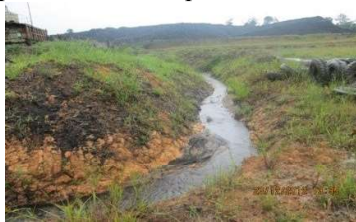
Gambar 2.4 Drainase Terbuka Pada Intermediate Stockpile [4]
