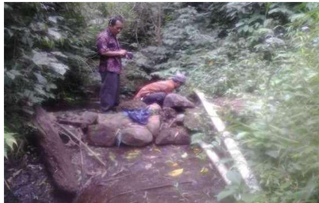
Gambar 3. Bangunan Pengambilan Eksisting
