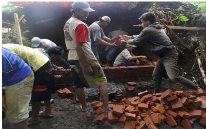
Gambar 7. Pembuatan Tandon Air
