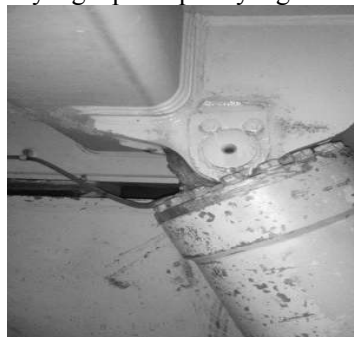
Gambar 3. Hasil modifikasi pada keeper hoist
