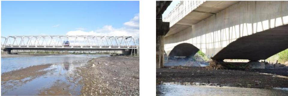
Gambar 1. Sedimentasi pada Pilar Jembatan Nasional Sungai Unda
