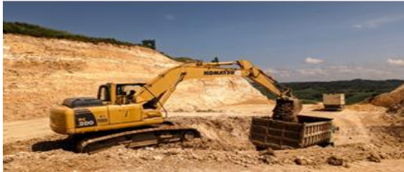
Gambar 4.1 galian tanah di STA 1+400
