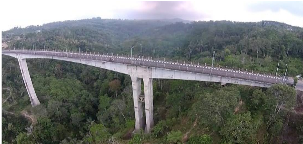
Gambar 3.3 Existing Jembatan Tukad Bangkung
