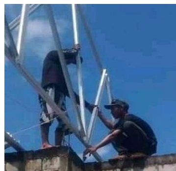
Gambar 2. Pekerja Bangunan (Sumber : Dokumen Pribadi)
