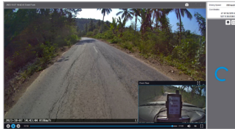
Gambar 3. Pengamatan Kerusakan Jalan Ruas Jalan (Waiwerang-Lite)-Lamawohong
