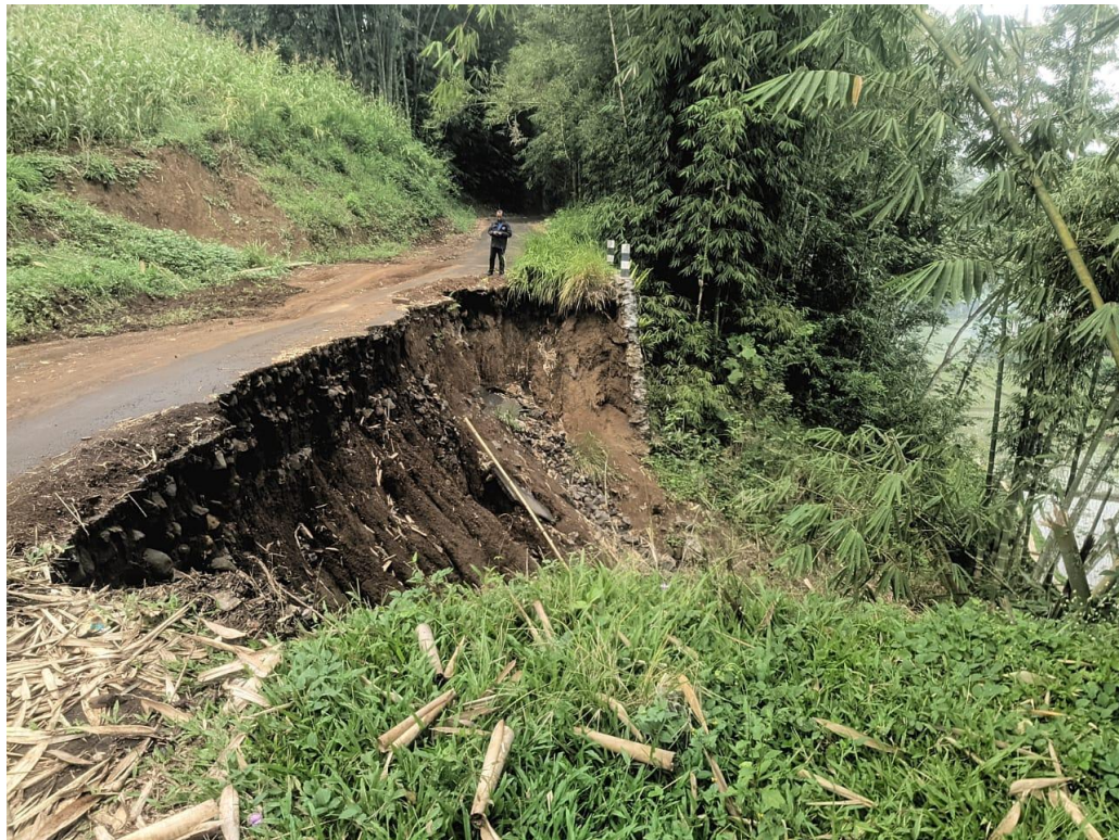
Gambar 4. Kondisi Lokasi Perencanaan Dinding Penahan Jalan Desa Telogosari Kec. Tirtoyudo Kab. Malang
