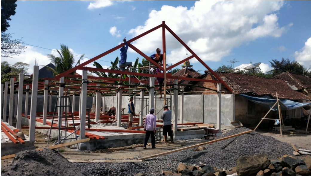
Gambar 11 Pekerjaan Rangka Atap
