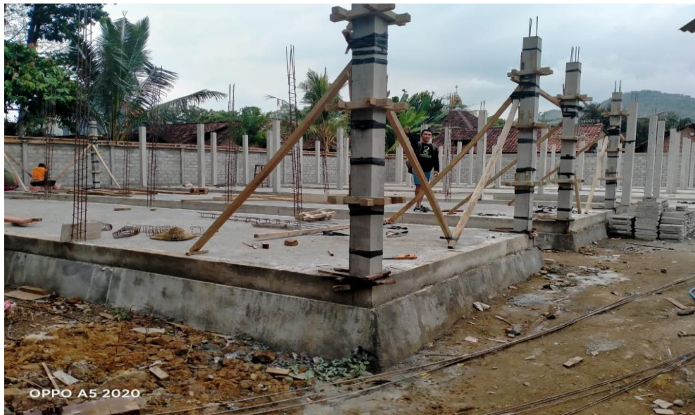
Gambar 10 Pekerjaan Pondasi, Sloof dan Kolom.
