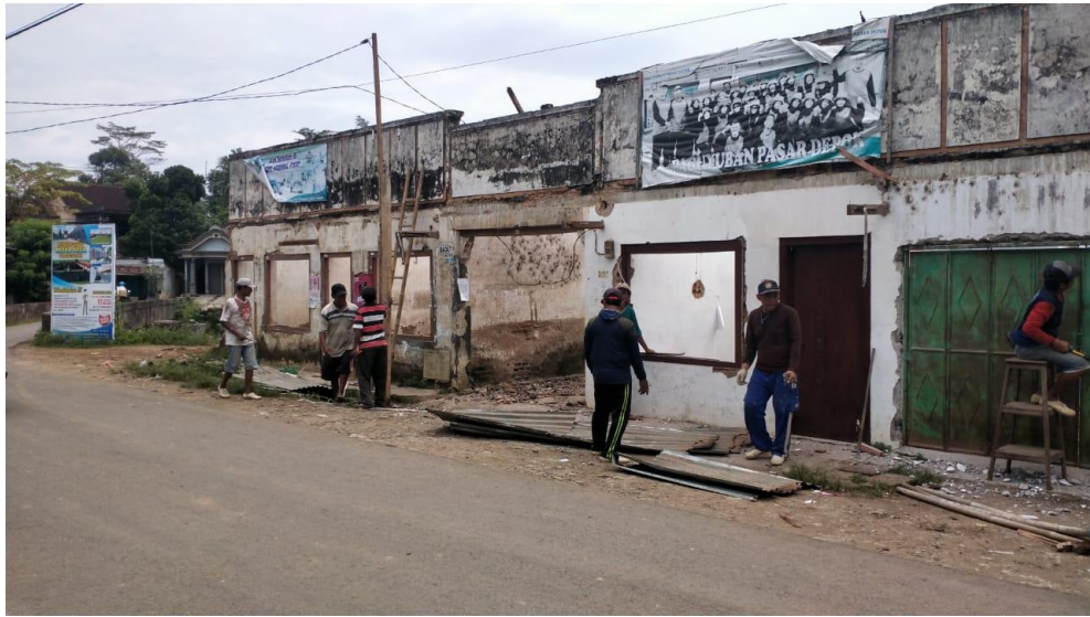
Gambar 2. Kondisi Pasar yang mulai di bongkar
