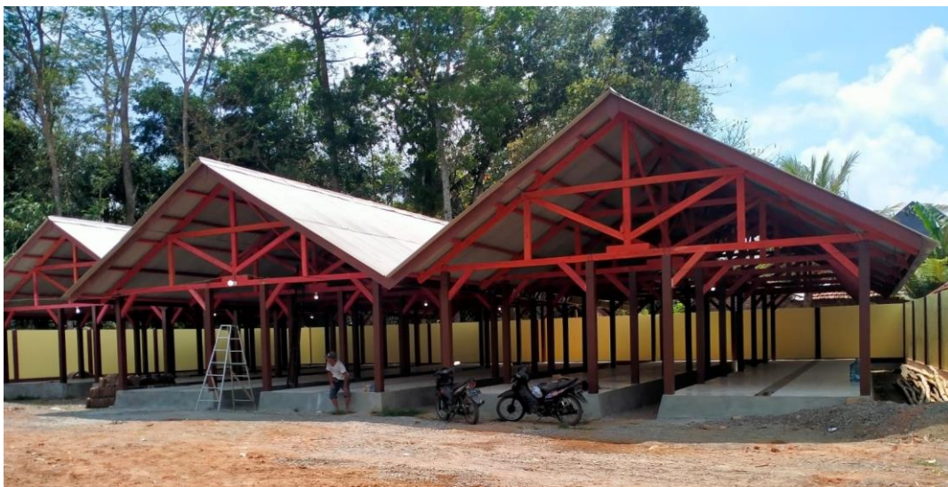
Gambar 12. Pekerjaan Pembangunan Pasar Karanganyar yang sudah selesai
