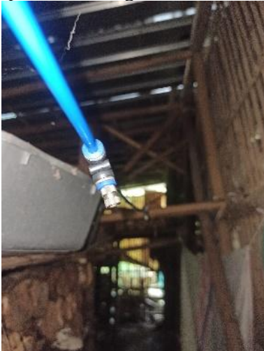
Gambar 11. Pemasangan nozzle
