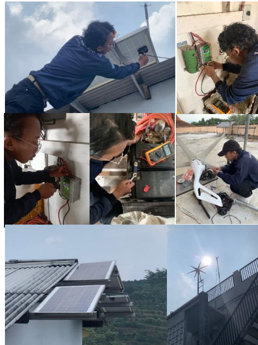
Gambar 7. Proses pemasangan system
