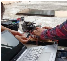
Gambar 23. Proses Pemasangan Pembangkit Panel Surya
