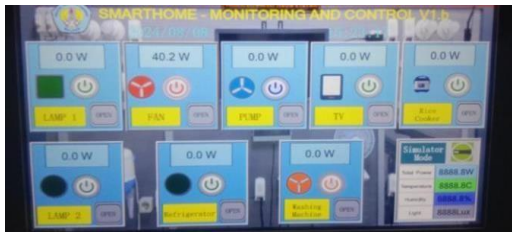
Gambar 24 . Tampilan monitoringnpada scada
