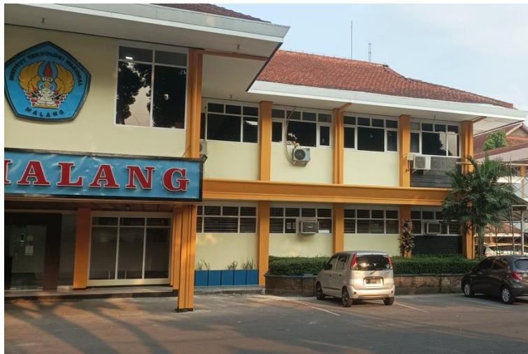
Gambar 1. Gedung Pusat Institut Teknologi Nasional Malang Sumber: Dokumentasi Pribadi (2024)
