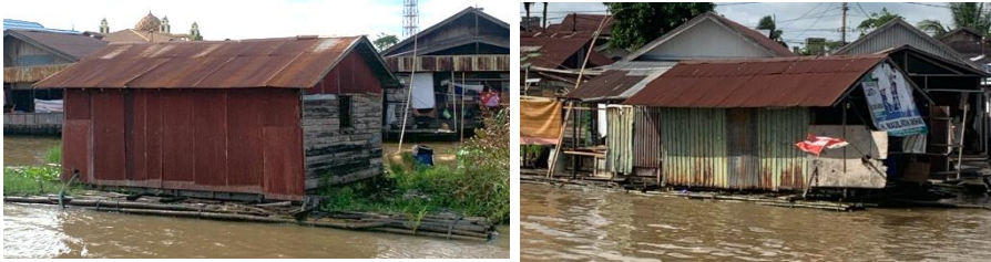
Gambar. 4 Tipe Rumah Lanting Pondasi Bambu. Sumber: Survei, 2024
