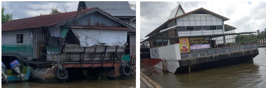
Gambar. 8 Tipe Rumah Lanting Pondasi Baja Sumber: Survei, 2024
