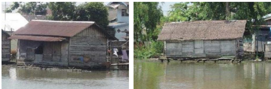
Gambar. 2 Tipe Rumah Lanting Pondasi Kayu Gelondongan. Sumber: Survei, 2024
