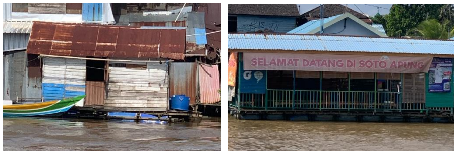
Gambar. 6 Tipe Rumah Lanting Pondasi Drum. Sumber: Survei, 2024
