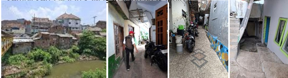
Gambar. 2 Kondisi bangunan di RW 003 Kelurahan Samaan Sumber: Survey (2024)
