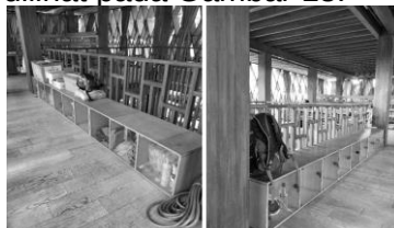
Gambar 13. Kondisi Loker Box
