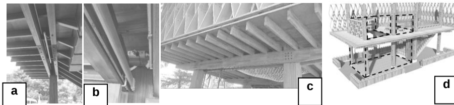
Gambar 6. Detail Balok dan Struktur
