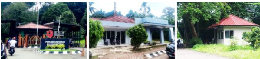
Gambar. 12 Kantor security, pos gerbang dan pos kecil di perumahan dinas Puspiptek.
