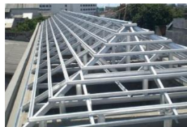
Gambar 9. Kerangka Atap Menggunakan Baja Ringan Sumber: Google, 2023
