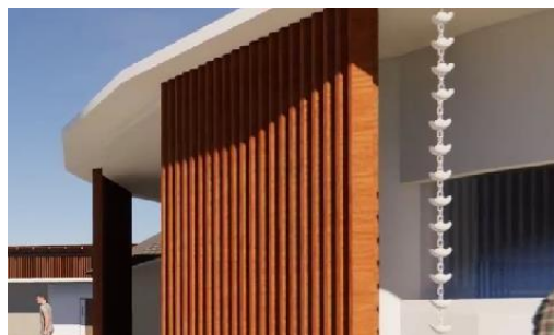
Gambar 5 Kolom pada bangunan Sumber : Analisa, 2024
