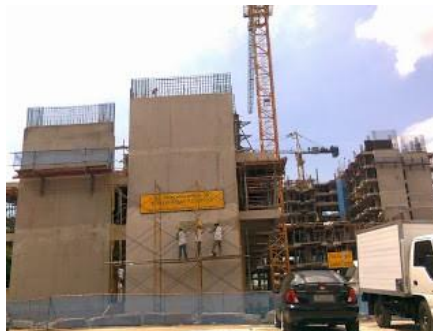
Gambar 5 Sumber: (Data Pribadi) Dinding shear wall
