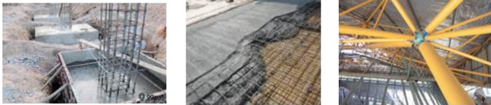
Gambar 7. Konsep Struktur Samping Kiri : Pondasi Telapak Tengah : Plat Beton Samping Kanan : Space frame Sumber : Analisa Pribadi, 2021
