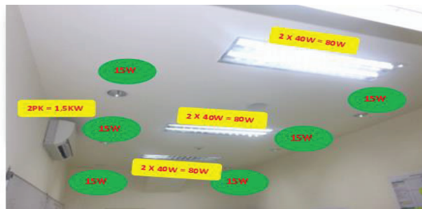
Gambar 1. lokasi (Zona), Lampu dan AC di perkantoran
