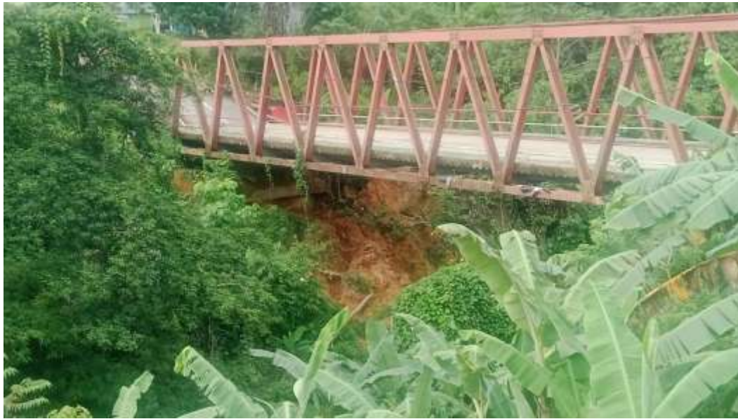
Gambar 06. Material tanah di bawah jembatan saat air sungai mengalami rapid draw down
