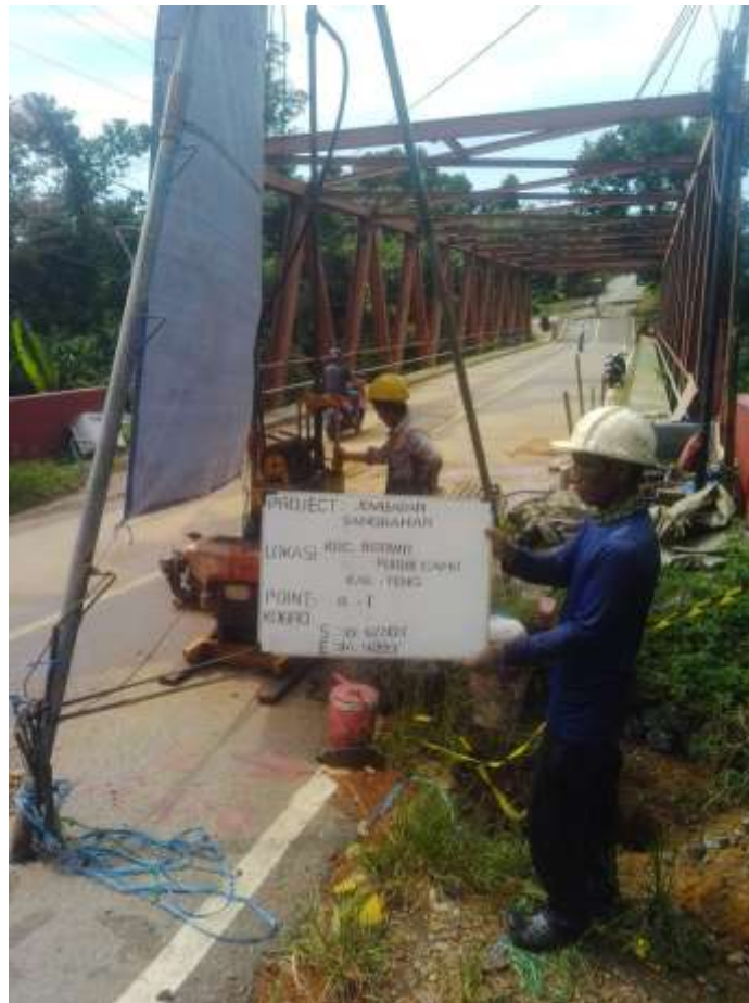
Gambar 04. Bentuk jembatan yang melengkung ke bawah dilihat dari BH-01 (timur)
