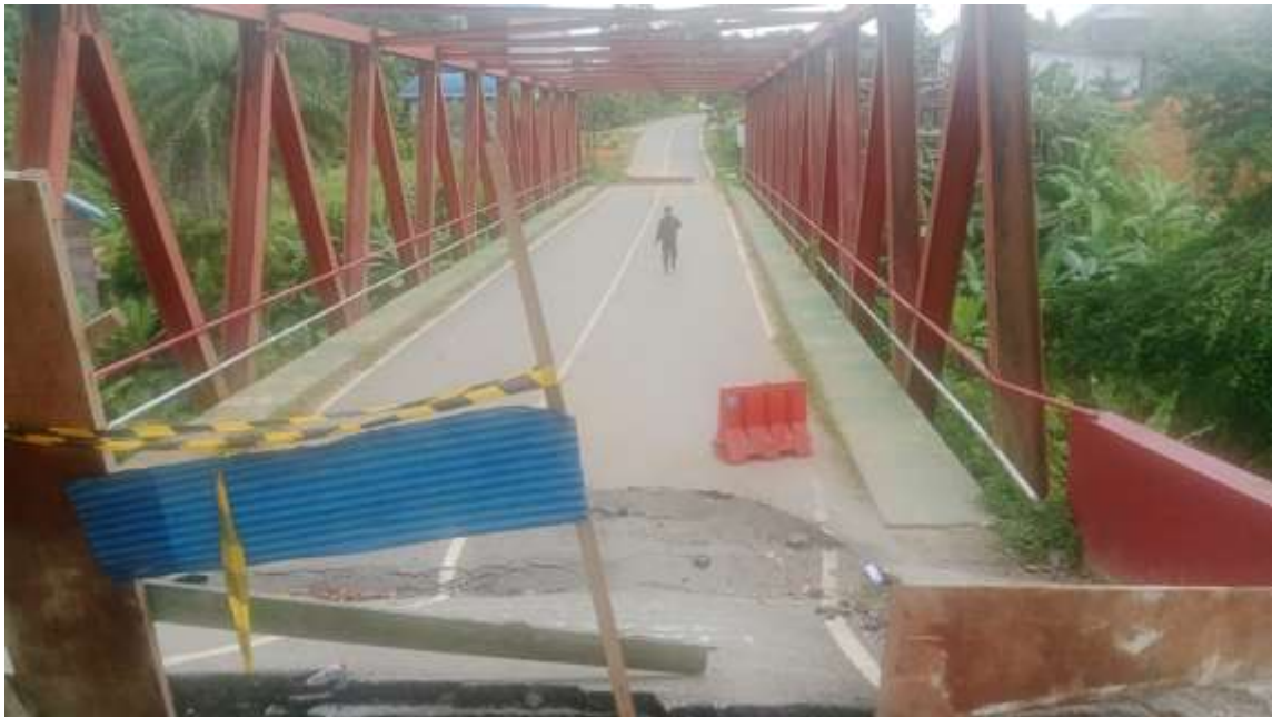
Gambar 03. Bentuk jembatan yang melengkung ke bawah dilihat dari BH-02 (barat)
